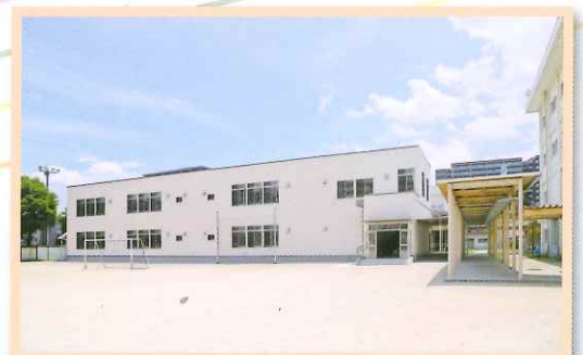
令和4年4月 体育館横に普通教室棟完成
